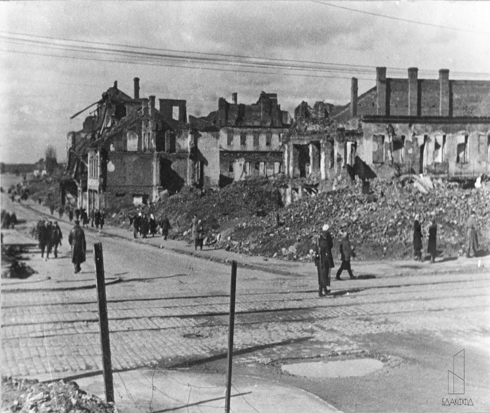
Минск. Разрушения по Ленинской улице.
